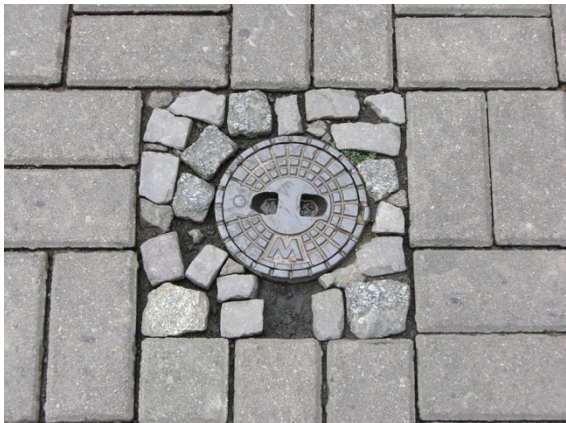
Einbaubild mit üblichen Wasserkappen
