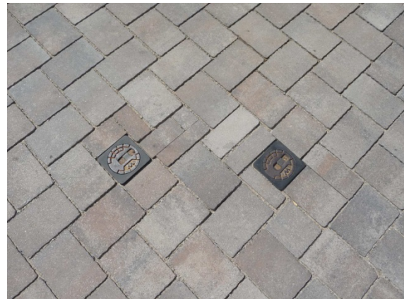
Einbaubild mit Pflasterkappen
